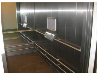
Aufzugskabine und die horizontal angeordneten Bedienelemente
