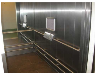
Aufzugskabine und die horizontal angeordneten Bedienelemente
