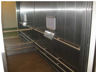
Aufzugskabine und die horizontal angeordneten Bedienelemente
